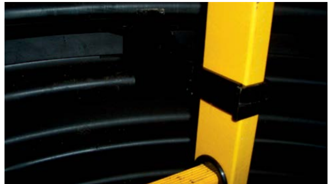
Рис. 7. Установка заглушек в кронштейны.
